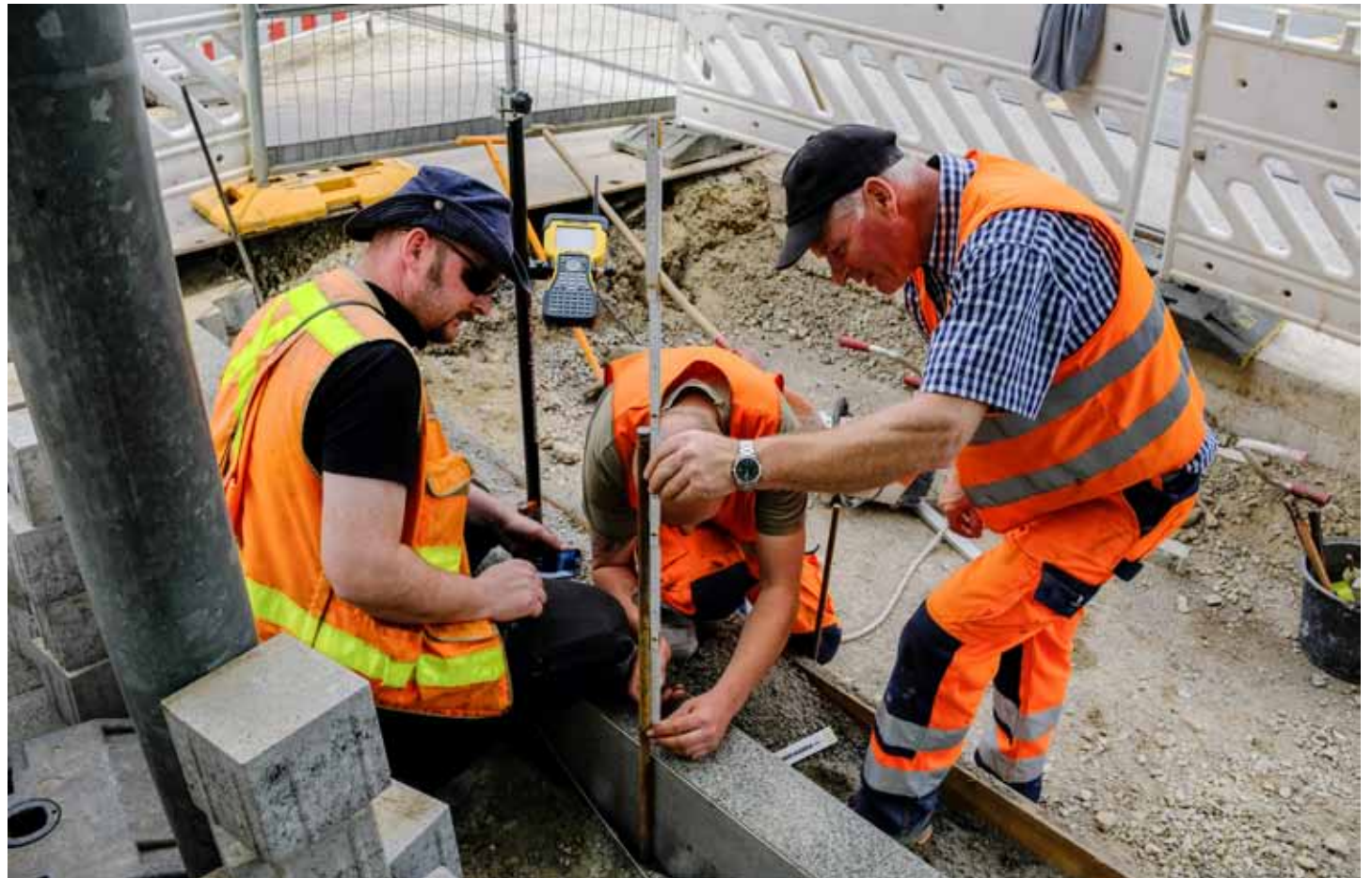
Frank Wöhlecke (rechts) kontrolliert, ob der Bordstein richtig gesetzt wurde. Hier wird auf den Zentimeter genau gearbeitet.
